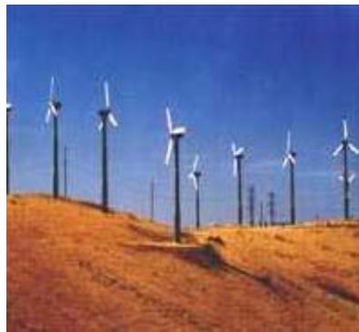
Turbinas de viento.
